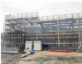
＜浸出水処理施設外観＞
