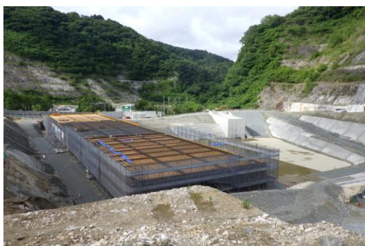
＜天井部分のコンクリート打設前＞
