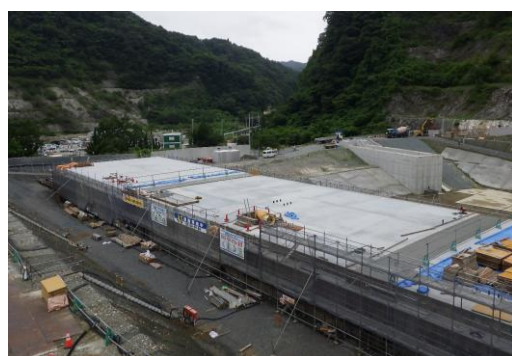
＜天井部分のコンクリート打設完了後＞
