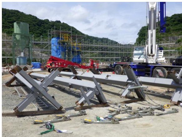
＜鉄骨の搬入状況＞
