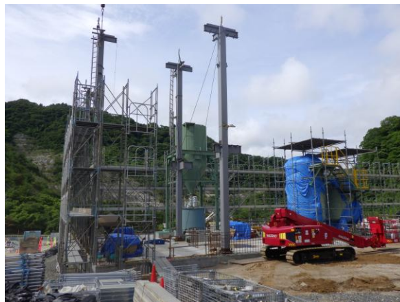
＜鉄骨の設置状況＞
