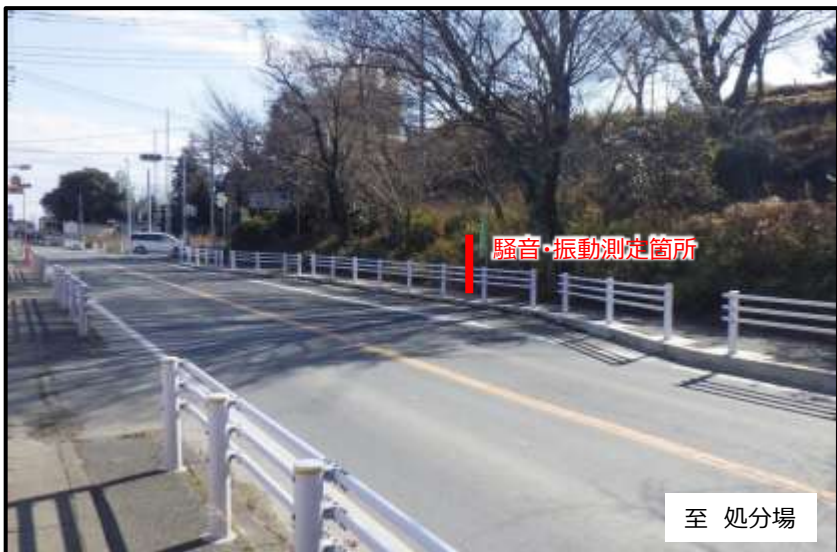
梅林通り 騒音・振動測定地点の様子
