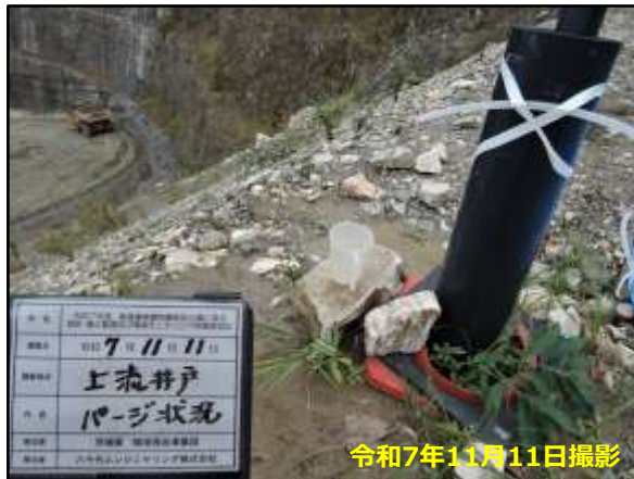
上流側モニタリング孔採水状況
