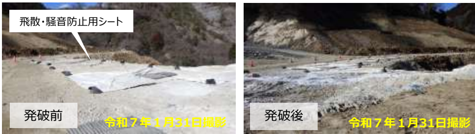
浸出水処理施設付近での発破の様子
