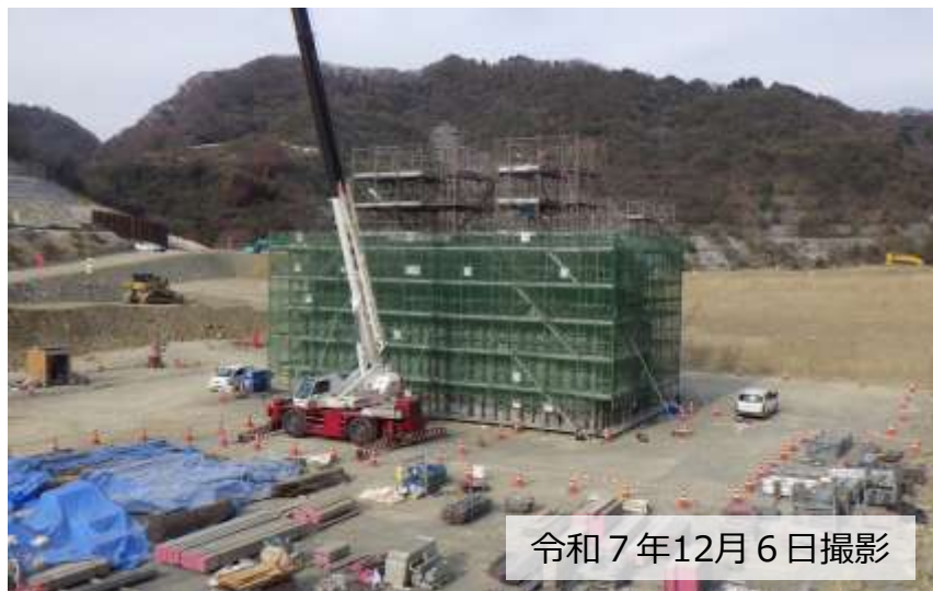
浸出水地下水集水ピットの築造状況
