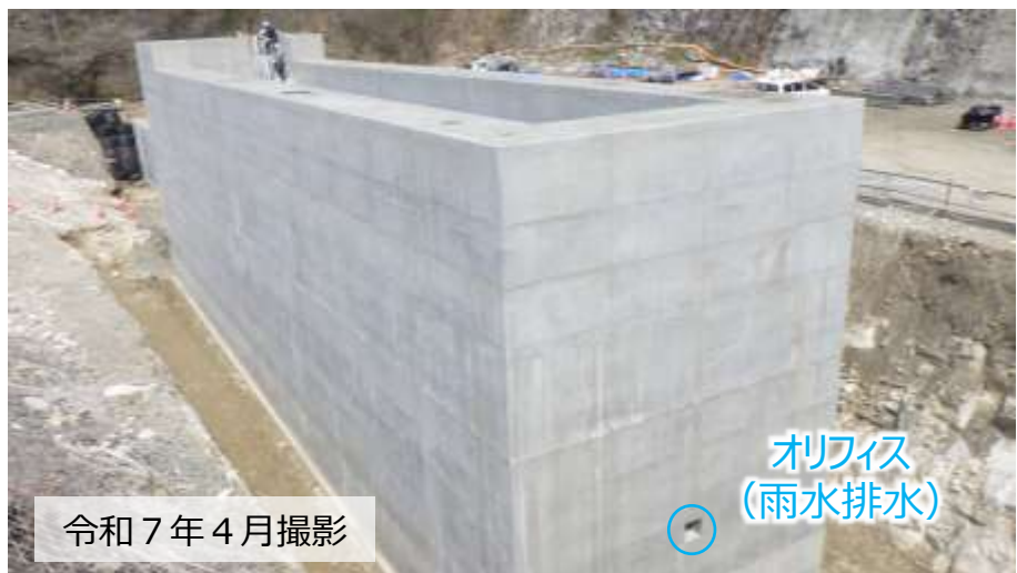
防災調整池 放流塔
