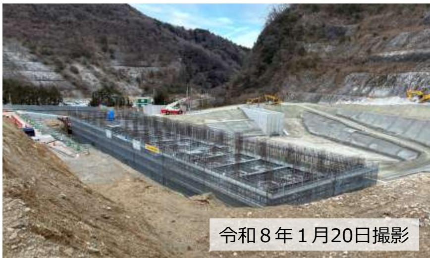
第1 浸出水調整槽の築造状況
