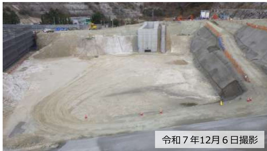
防災調整池の造成状況
