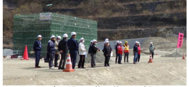
＜工事現場での施工状況の確認＞
