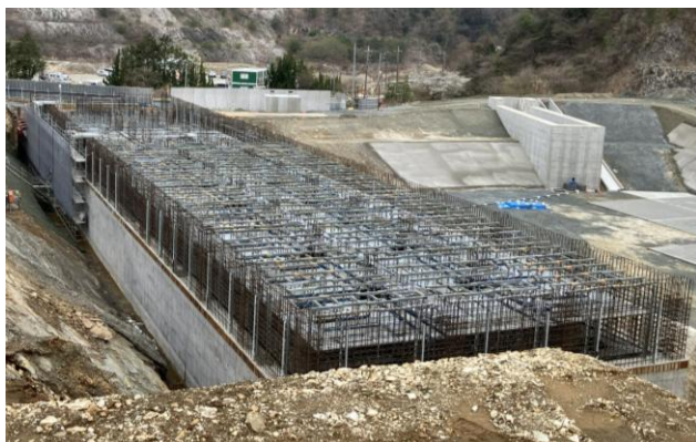
<第1浸出水調整槽の施工状況>
