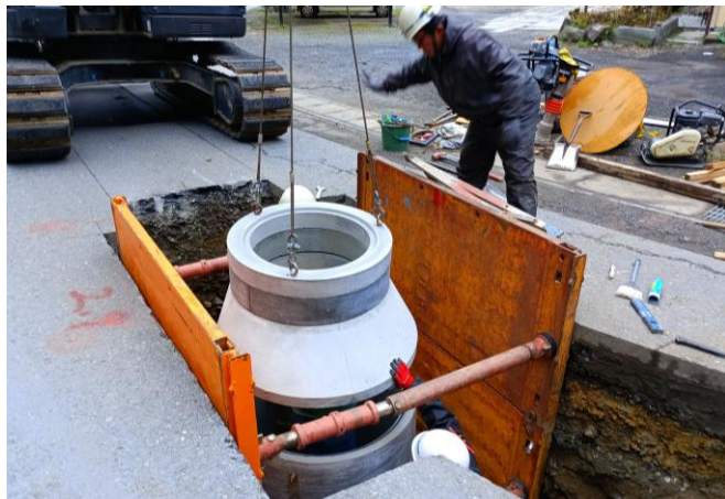
＜開削工事(マンホールの敷設状況)＞
