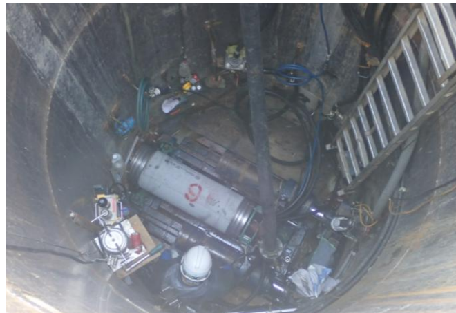
＜推進工事(垂直に掘られた立坑内の作業状況)＞
