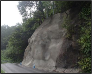
モルタル吹付工施工イメージ
