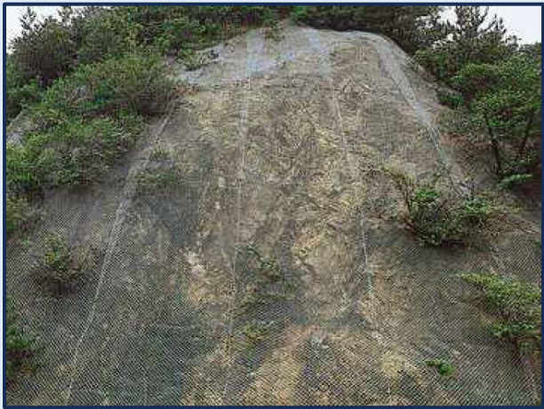
主に石灰岩（弱ゆるみ部）の浮石の落下防止を目的に落石防護対策を行う。
