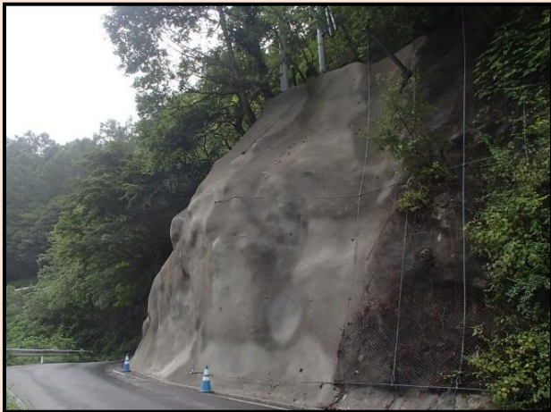
主に粘板岩（中ゆるみ部～土砂状部）の風化、浸食防止と石灰岩等含む落石防止を目的に対策を行う。
