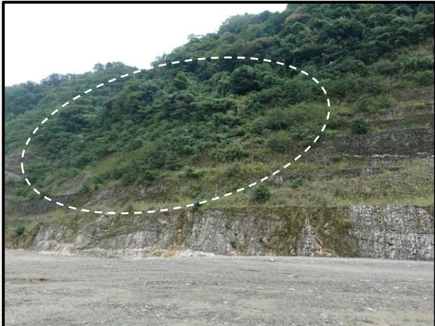
樹木等が広範囲に繁茂している箇所は、伐採等により安定した状態を毀損する可能性があるため、無対策とする
