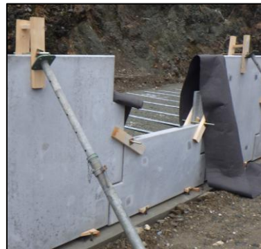
＜帯鋼補強土壁＞
