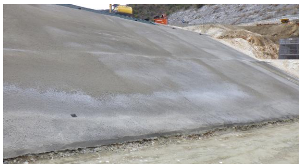
＜コンクリート吹付工事＞
