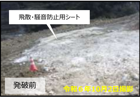
仮設道路付近での発破の様子
