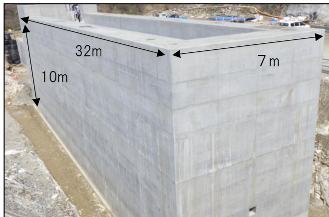
放流塔の完成状況
