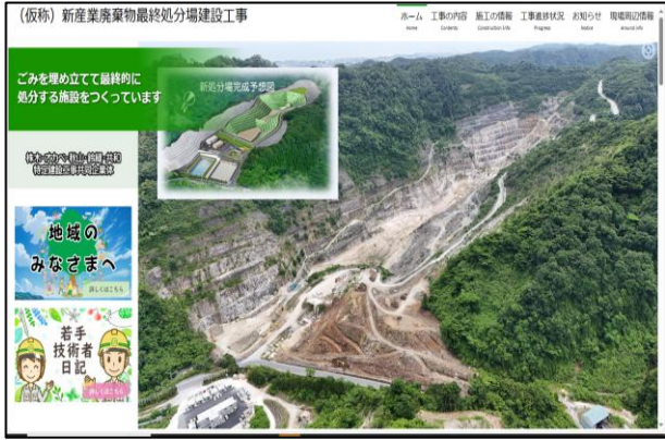
【施工者ホームページの開設】
