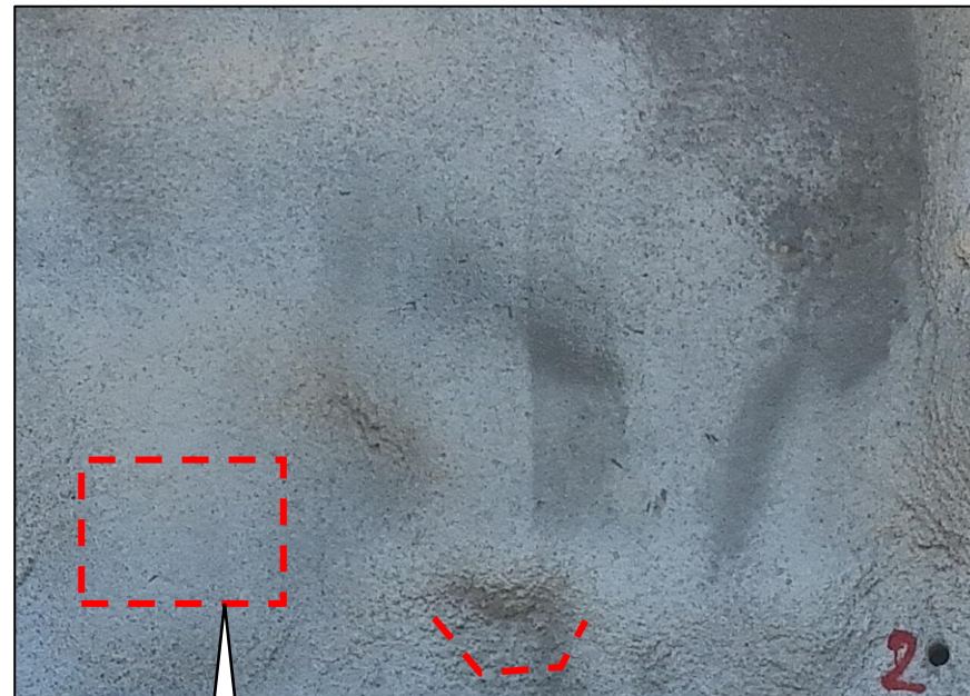
繊維補強モルタル吹付（機械施工）
