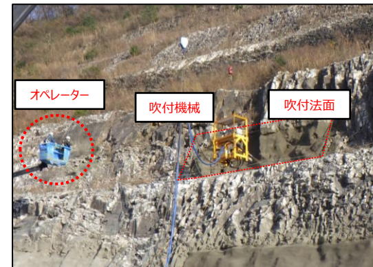
機械吹付の状況
