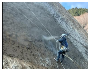
人力吹付の状況
