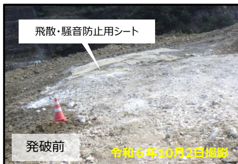
仮設道路付近での発破の様子
