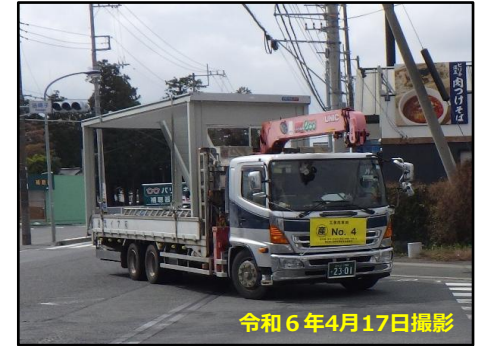
工事用車両 (油绳子交差点)
