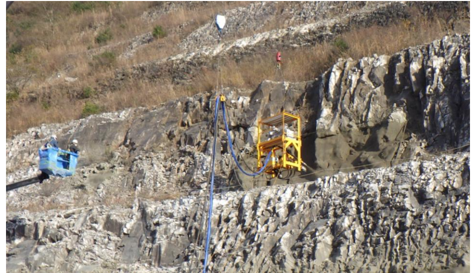
<遠隔操作によるモルタル吹付試験状況>
