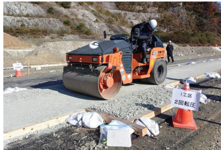
<ベントナイト砕石試験施工(転圧)>
