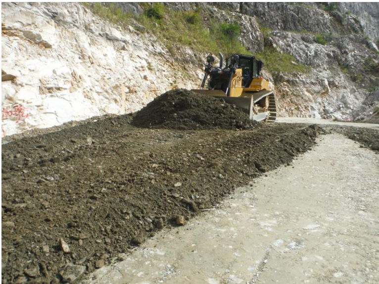
<ブルドーザーによる敷均し>
