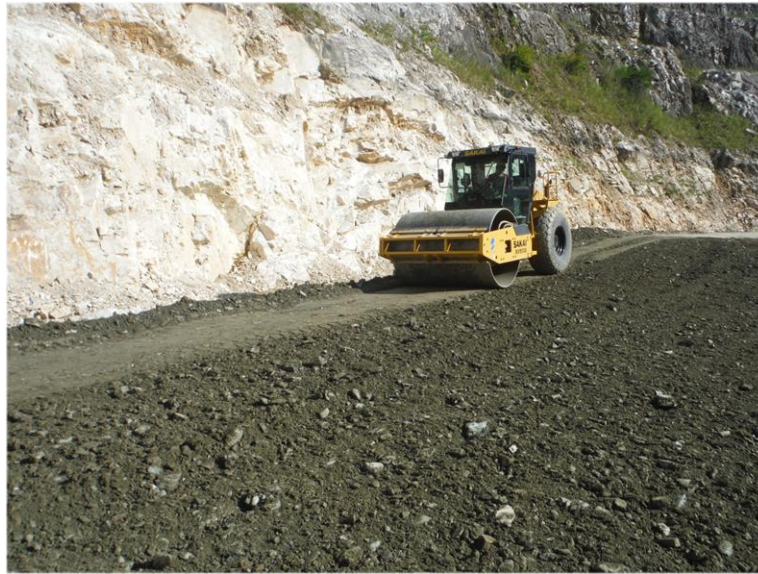
<振動ローラーによる締固め>
