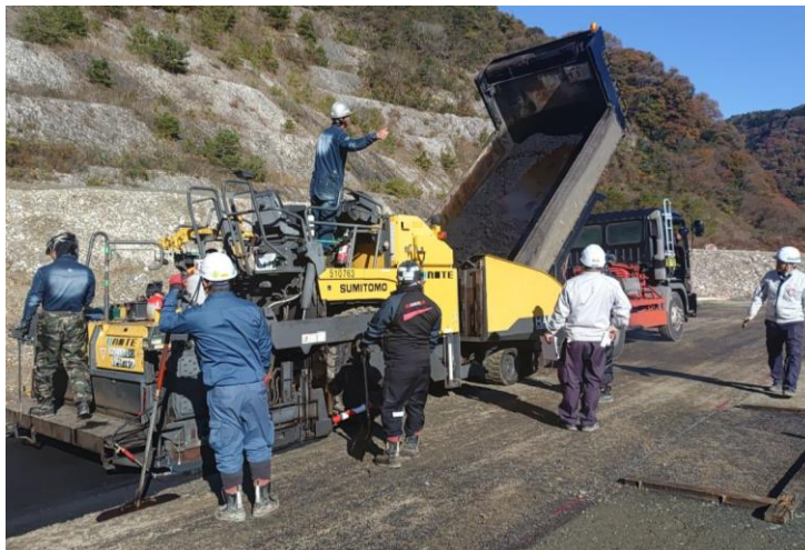
<水密アスファルトコンクリート試験施工(敷き均し)>
