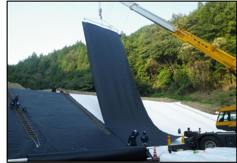
遮水シート施工状況
