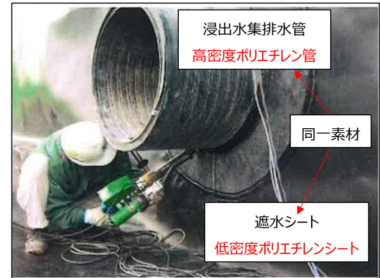
浸出水管貫通部施工状況
