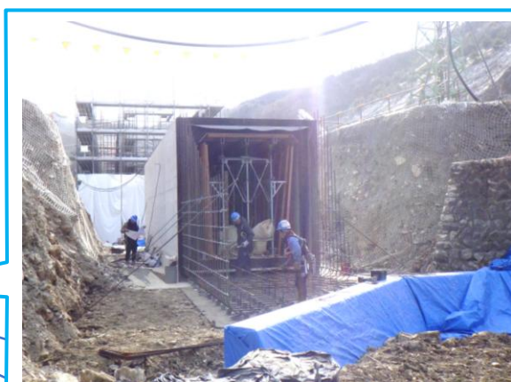
吐け口工の整備状況(鉄筋の組立作業)
