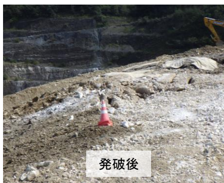
堆積場からの仮設道路を整備するための発破の様子
