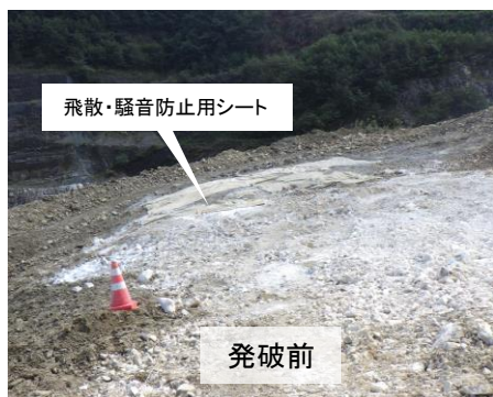
堆積場からの仮設道路を整備するための発破の様子
