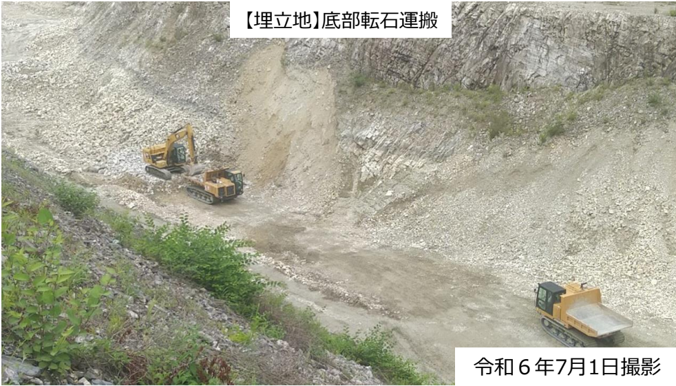
【埋立地】底部基盤整備
