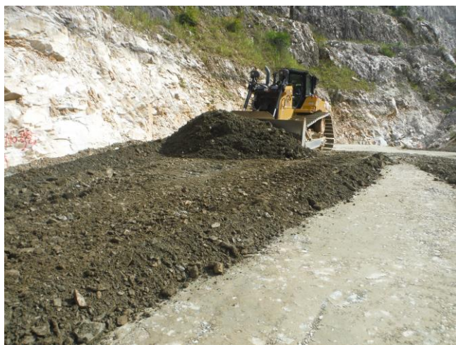
ブルドーザーでの盛土材料の敷均し
