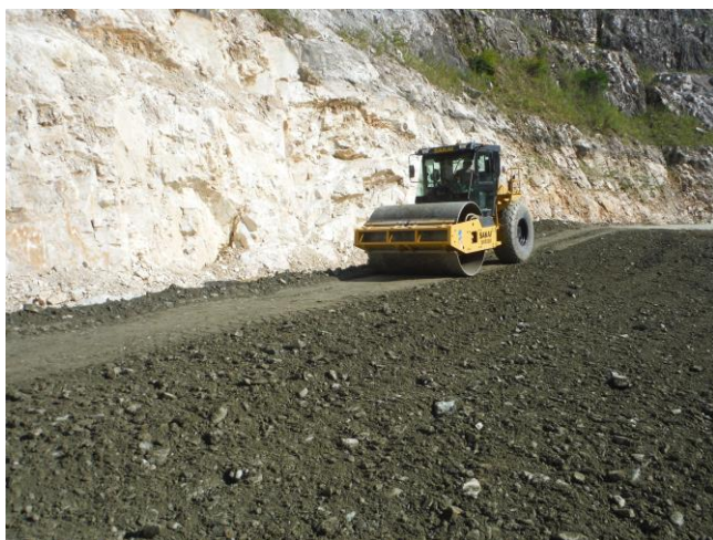
振動ローラーでの締固め
