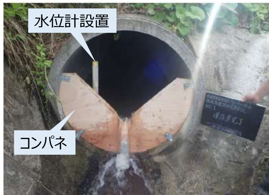
(a) 地点1の土管への設置方法
